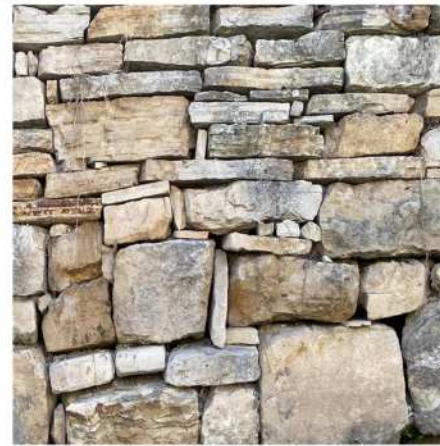
Τοιχοποιία με οριζόντια διάταξη διαφορετικού μεγέθους λίθων με πλακοειδής μορφή (χρήση ραμμάτων)
