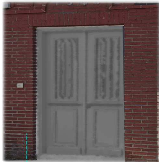
ΠΟΡΤΑ ΤΗΣ ΟΠΟΙΑΣ ΤΟ ΠΕΡΙΘΥΡΩΜΑ ΕΙΝΑΙ ΚΑΤΑΣΚΕΥΑΣΜΕΝΗ ΑΠΟ ΤΟΥΒΛΑΚΙΑ
