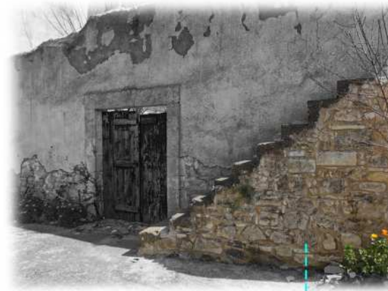
ΠΕΤΡΟΚΤΙΣΤΗ ΣΚΑΛΑ, ΤΑ ΣΚΑΛΟΠΑΤΙΑ ΤΗΣ ΟΠΟΙΑΣ ΚΑΛΥΦΘΗΚΑΝ ΑΠΟ ΜΗΕΤΟΝ
