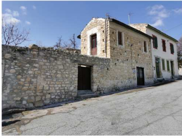
Κίνηση από δωμάτιο σε δωμάτιο για τη μετάβαση στην αυλή
