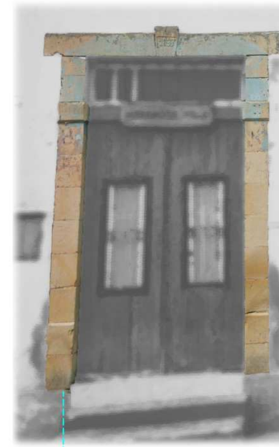
ΠΟΡΤΑ ΤΗΣ ΟΠΟΙΑΣ Η ΠΕΡΙΜΕΤΡΟΣ ΕΙΝΑΙ ΚΑΤΑΣΚΕΥΑΣΜΕΝΗ ΑΠΟ ΠΕΛΕΚΗΤΗ ΠΕΤΡΑ ΤΗΣ ΠΕΡΙΟΧΗΣ
