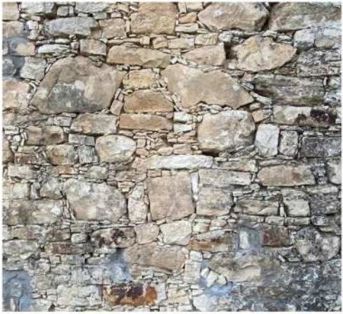
Τοιχοποιία με ακανόνιστη διάταξη με χρήση διαφορετικού μεγέθους λίθων.
