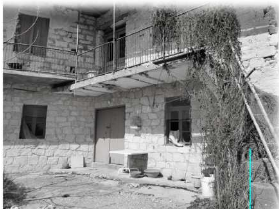
ΣΚΑΛΑ ΑΠΟ ΟΠΛΙΣΜΕΝΟ ΣΚΥΡΟΔΕΜΑ ΕΝΣΩΜΑΤΩΜΕΝΗ ΣΤΗΝ ΟΨΗ ΤΟΥ ΚΤΙΡΙΟΥ
